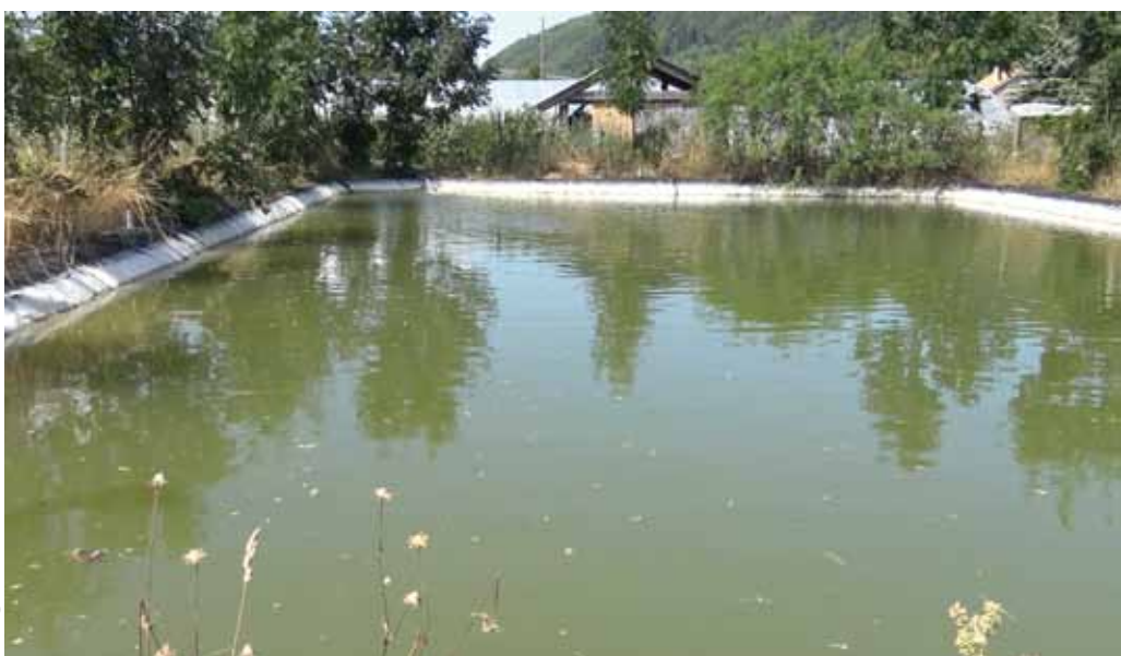
▼ Bassine Monestier de Clermont : micro-bassine de 300 m 3 , servant de réserve-tampon
